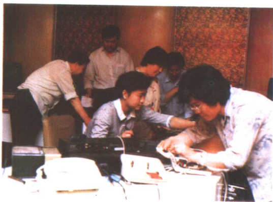
67. 1990年6月7日, 北京人民广播电台的技术人员正紧张地为北京经济台安装调试直播机房设备。 (北京人民广播电台供稿)
