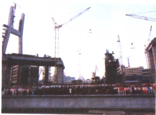
63. 上海电视台1990年国庆节目《跨越千年纪元》中千人合唱在上海黄浦大桥建设工地摄制。 (上海广播电视局供稿)
