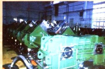
105m/s高线精轧机试车现场
