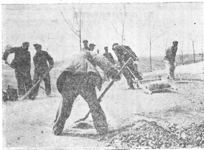
圖5 用石轆轤壓路面
