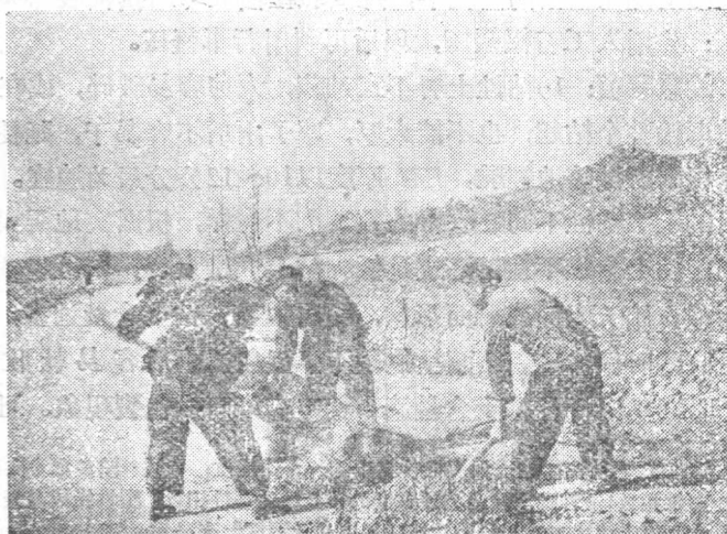
圖3 拌和改善土壤路面的材料
