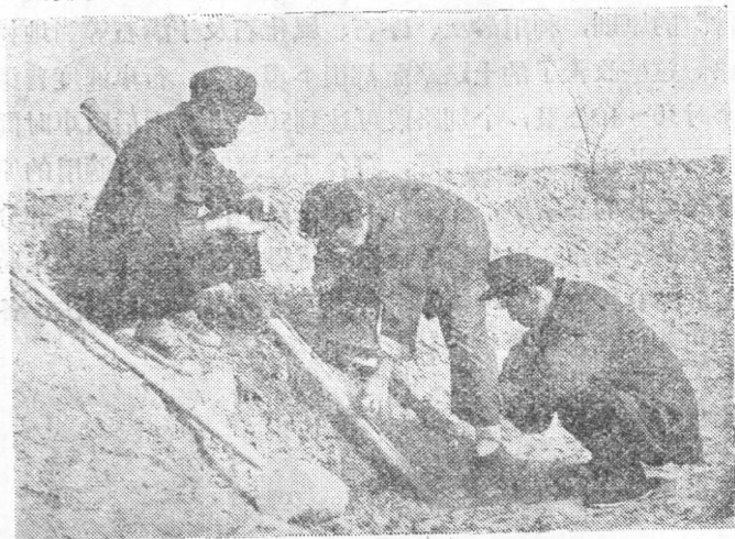
圖1 用木鑽探器鑽取土樣，看是否適合作为改善路面的材料的那种土），厚度自数公分至1公尺不等（一般是50~60公分）。
