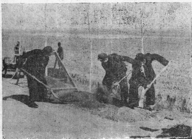
圖8 在公路兩旁采集砂礫粘土混合料
