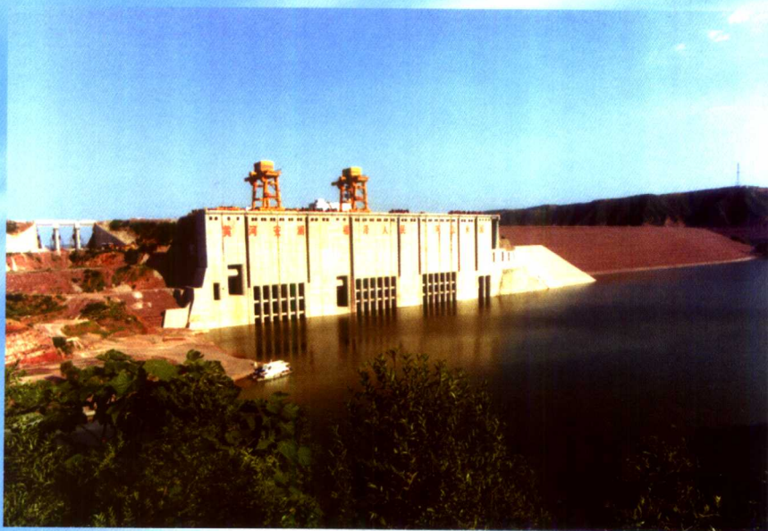
小浪底水利枢纽进水口
