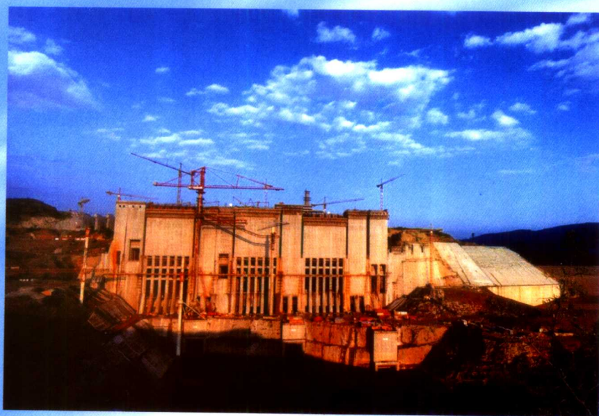
小浪底水利枢纽进水塔群
