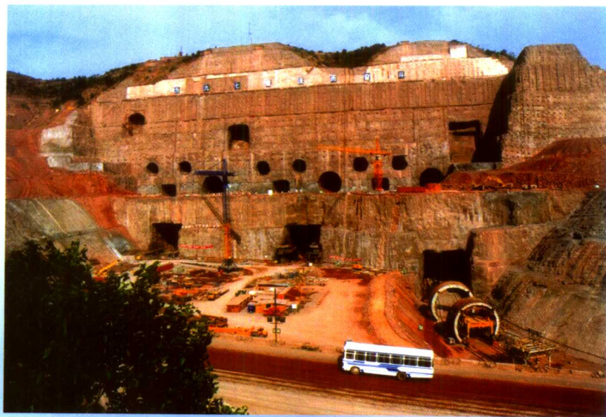
小浪底水利枢纽进水口高边坡施工
