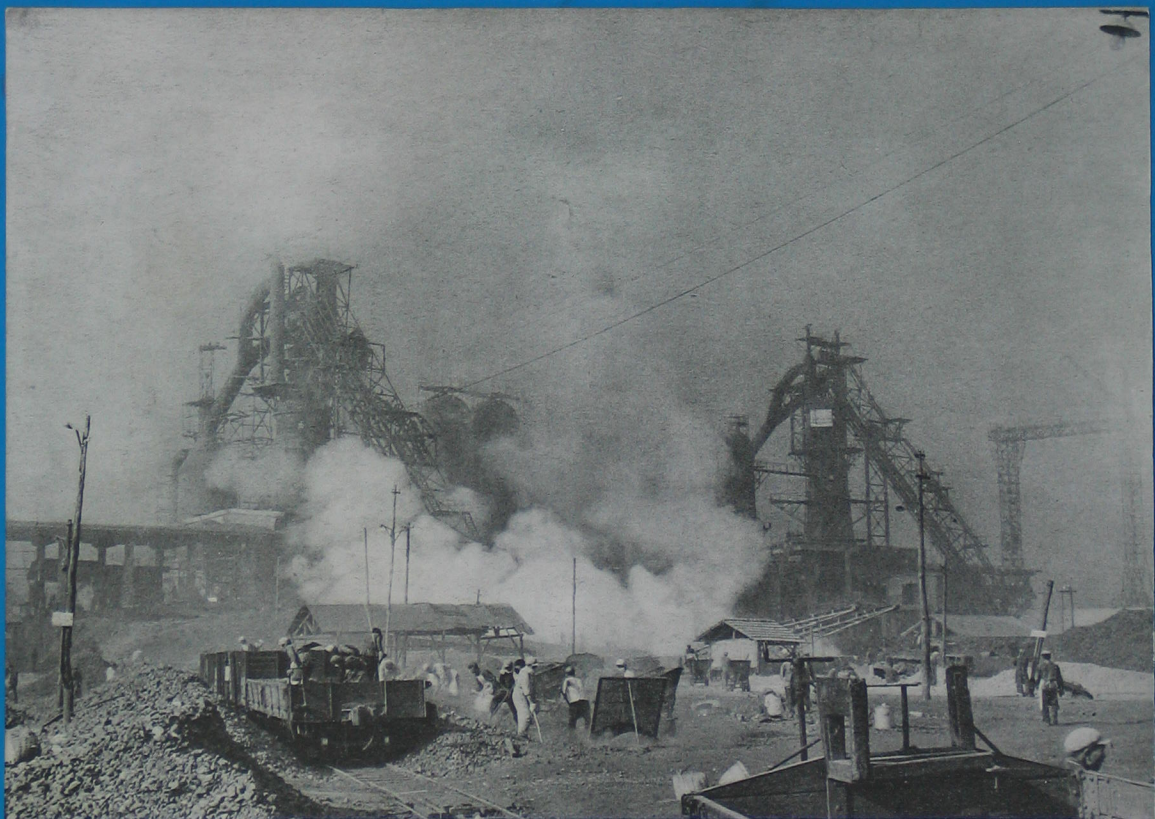
1958年开始扩建的新的钢铁联合企业——昆明钢铁公司第二、三号高炉
