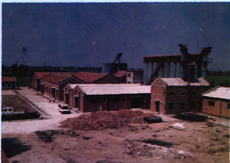
本院新建立的科技产业——混凝土外加剂生产厂。
