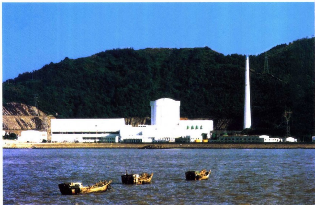
秦山一期 30 万千瓦压水堆核电站
