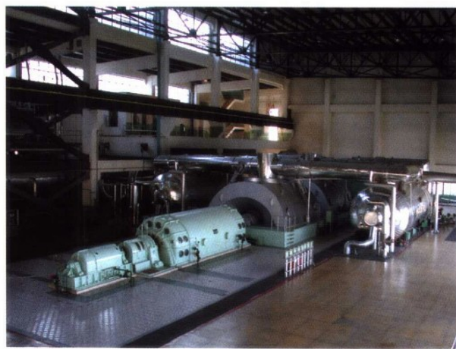
秦山一期核电站汽轮发电机组
