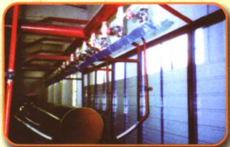
鋼管道環氧粉末三層PE防腐作業線
