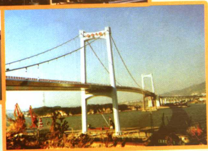
大桥钢箱梁防腐及摩擦面处理工程
