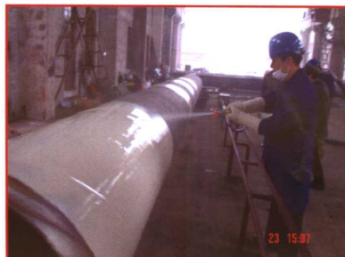
👍 常熟国际化园区管道
