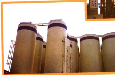
设备防腐保温工程
