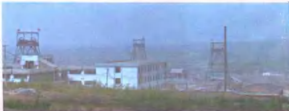
图为在建的大中型项目——梧桐庄矿
