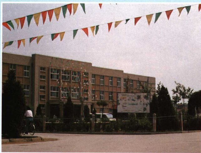
▲县医院门诊楼
