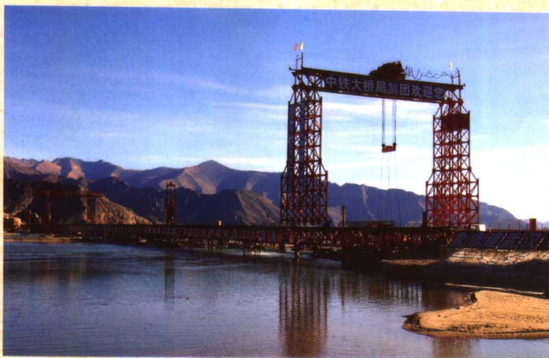
青藏铁路拉萨河特大桥工地
