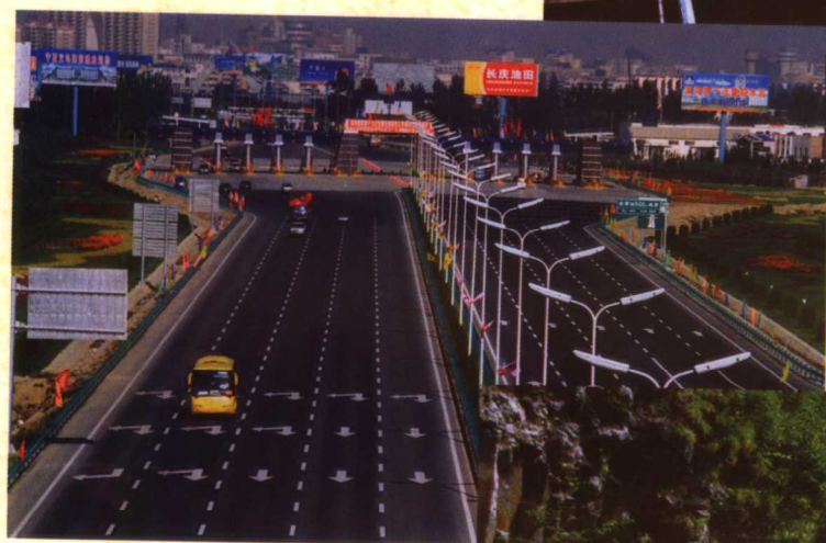
银川机场高速公路 宁夏交通厅供稿
