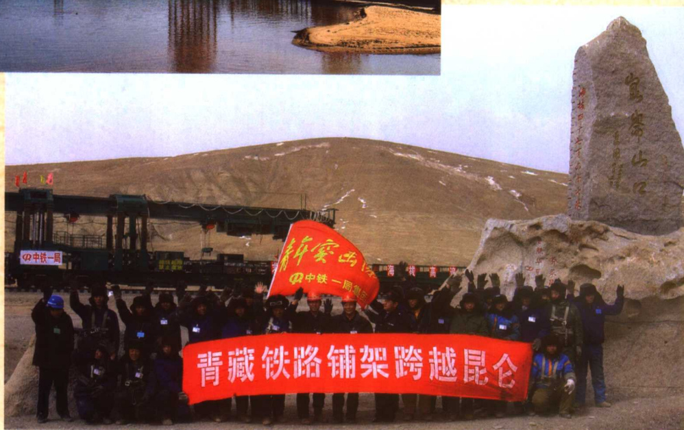
青藏铁路铺架通过了昆仑山隧道
