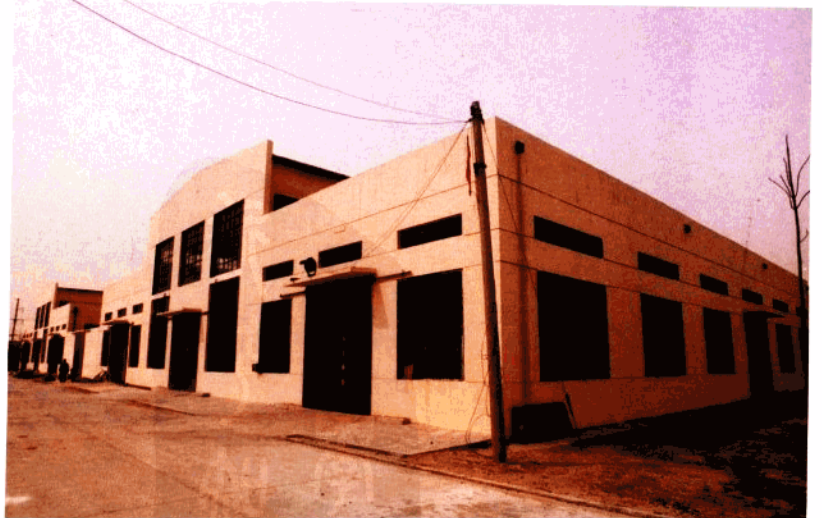
德州电力设备厂厂房
