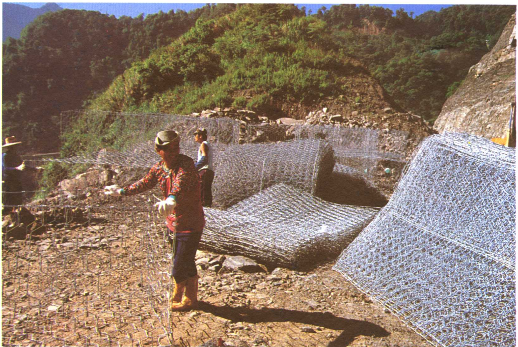
在山崩附近，有一羣人正在做維修的工作。這是比較先進的方形蛇籠，舊有蛇籠呈圓形。方形的好處，是沒有死角的產生；而且因為是方形，所以能兼顧各面壓力，它的使用壽命比一般圓形的更久。
