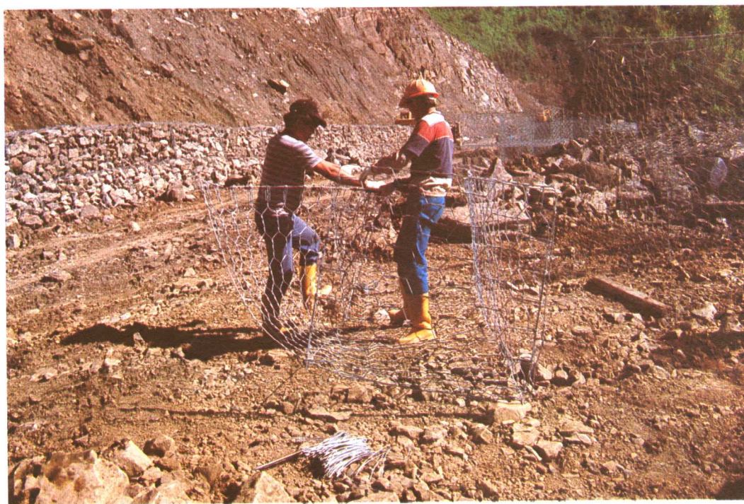
將工廠做好的蛇籠網狀規格化材料，加以簡單摺疊，作成立體狀。
