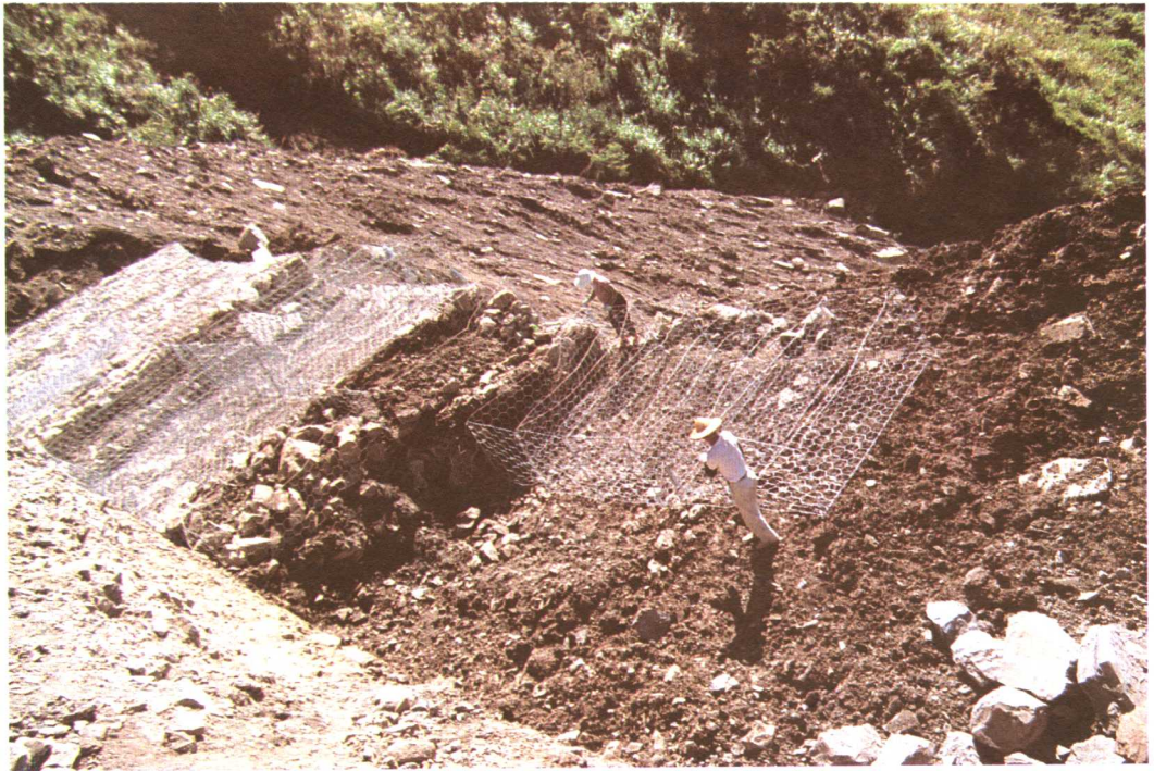
將方形蛇籠擺放在不穩定的斜坡旁，地基挖平後，再把蛇籠放上去；然後用怪手將崩落石塊放在裡面。這些全部是石頭，絕不能放入泥土，否則到時泥土流失掉，將會事倍功半。
