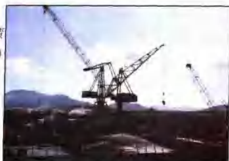
海南目前最大的綜合性水電工程——大廣壩水利水電樞紐工程正緊張施工 (張勇攝)
