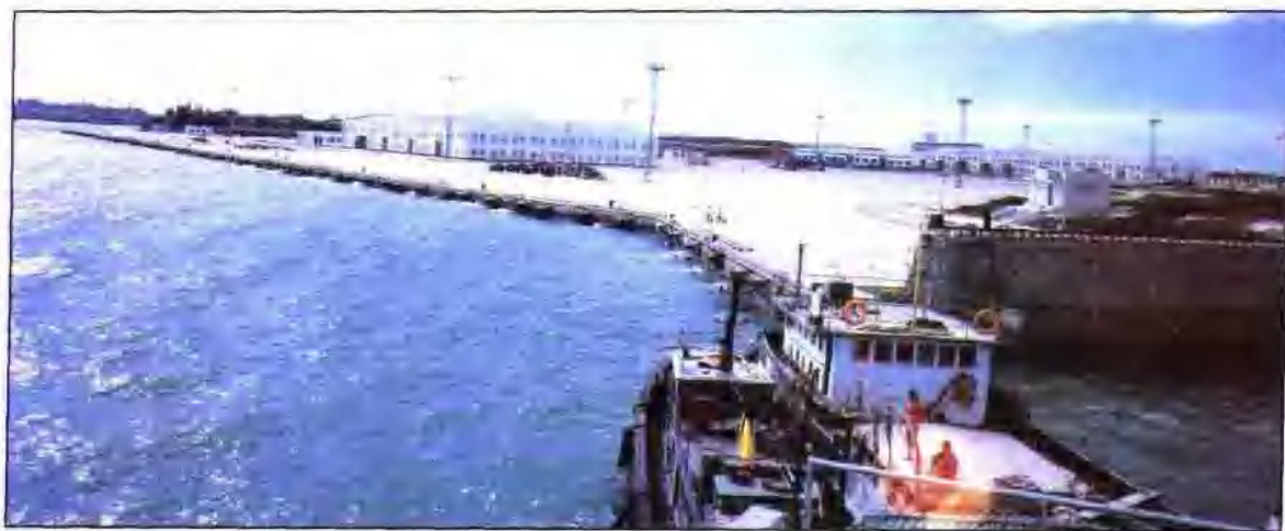
建設發展中的天然深水港——洋浦港。
