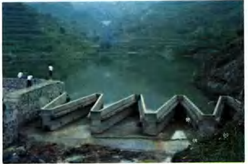
13. 园子台水库“迷宫堰”式溢洪道
