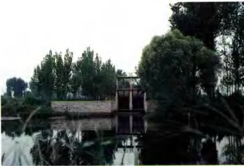
14. 引黄过清节制闸
