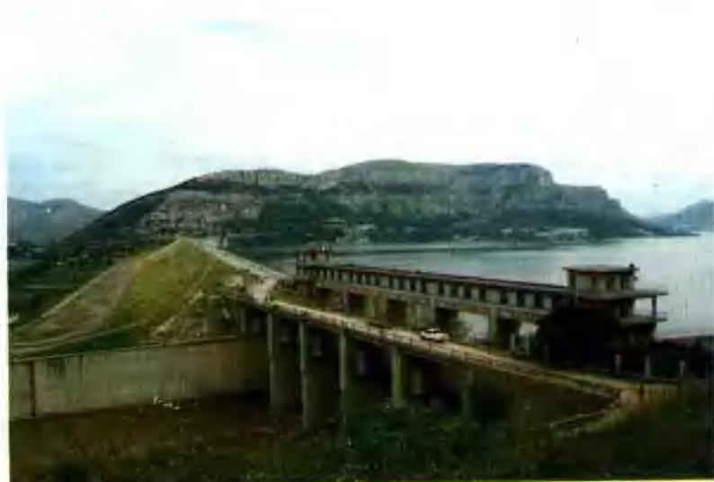
3. 卧虎山水库大坝
