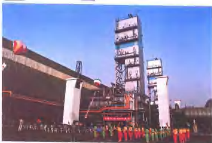
氧气液化装置竣工投产
