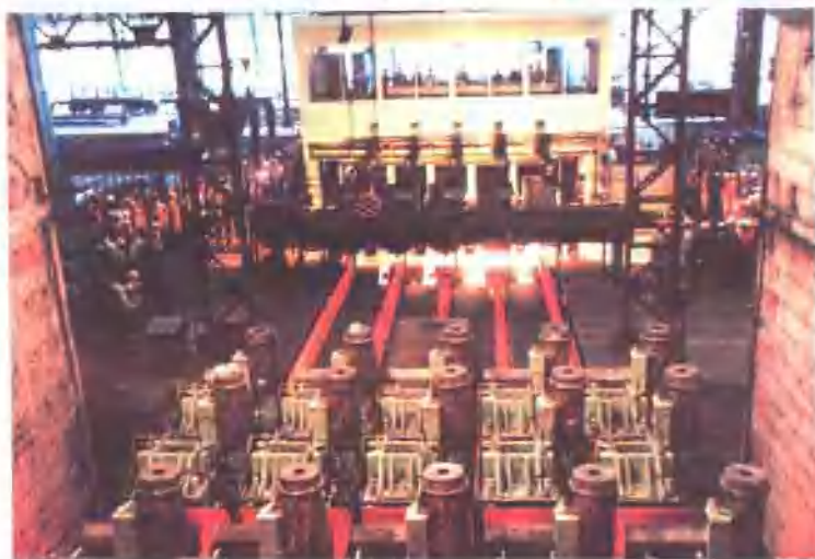
一炼钢1号连铸机 热负荷试运行出坯现场
