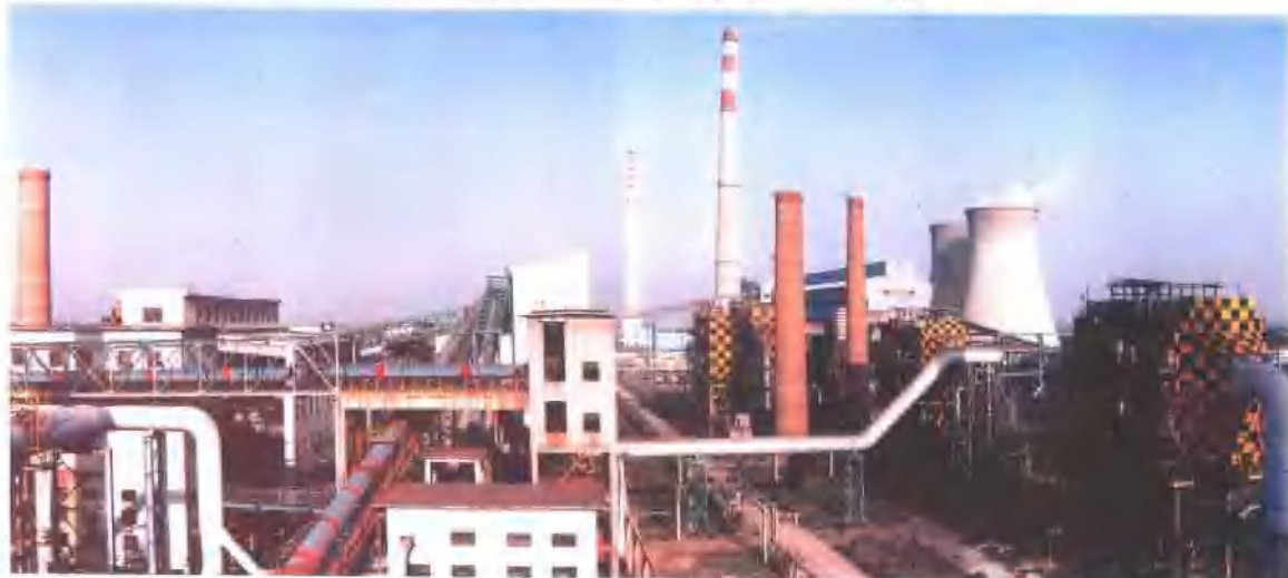
四烧工程外景
