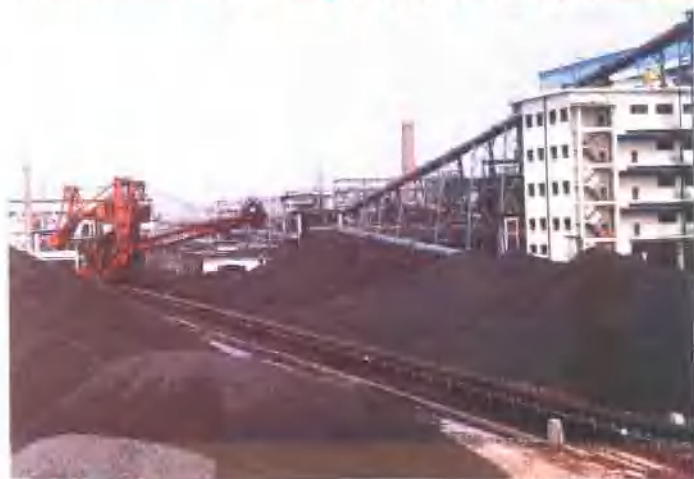
四烧工程原料场一角
