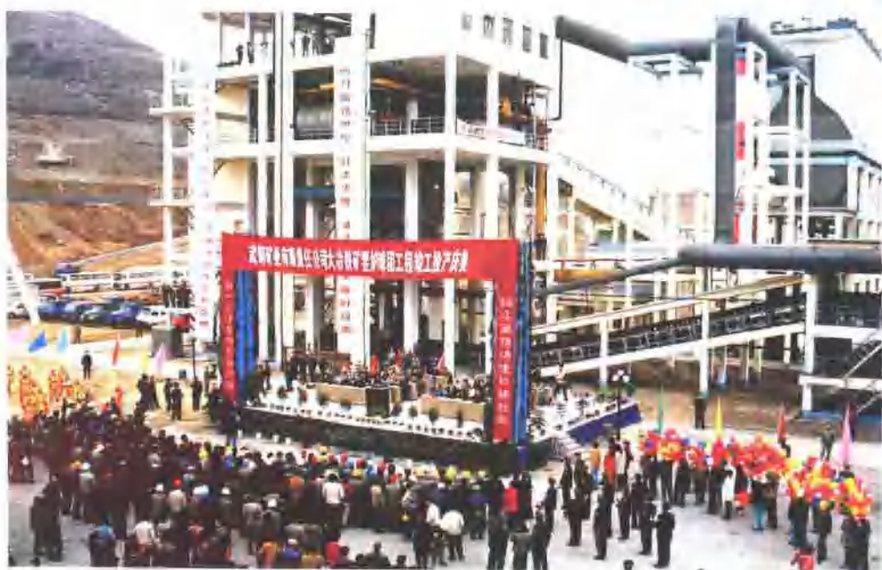
大冶铁矿竖井球团工程竣工典礼
