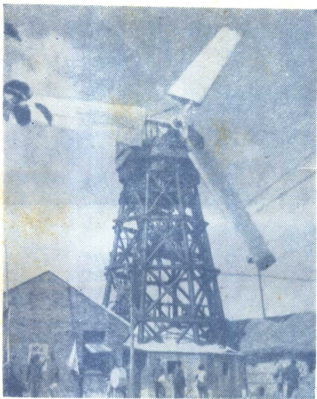
启东县海丰镇风力发电站外景
