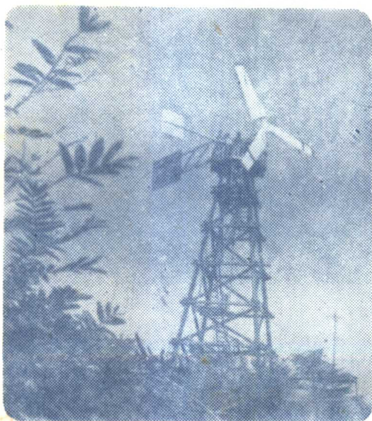
← 張黃港风力发电站全景
