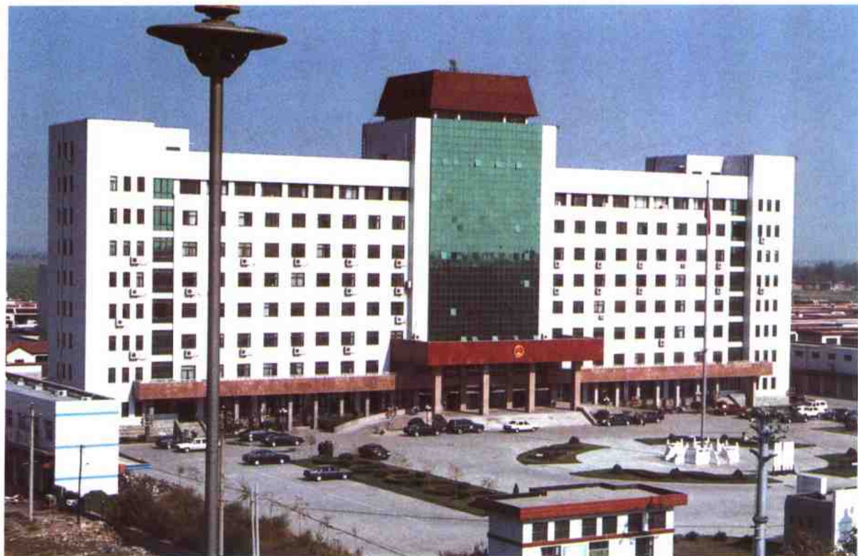
县委、政府、人大、政协综合办公楼
