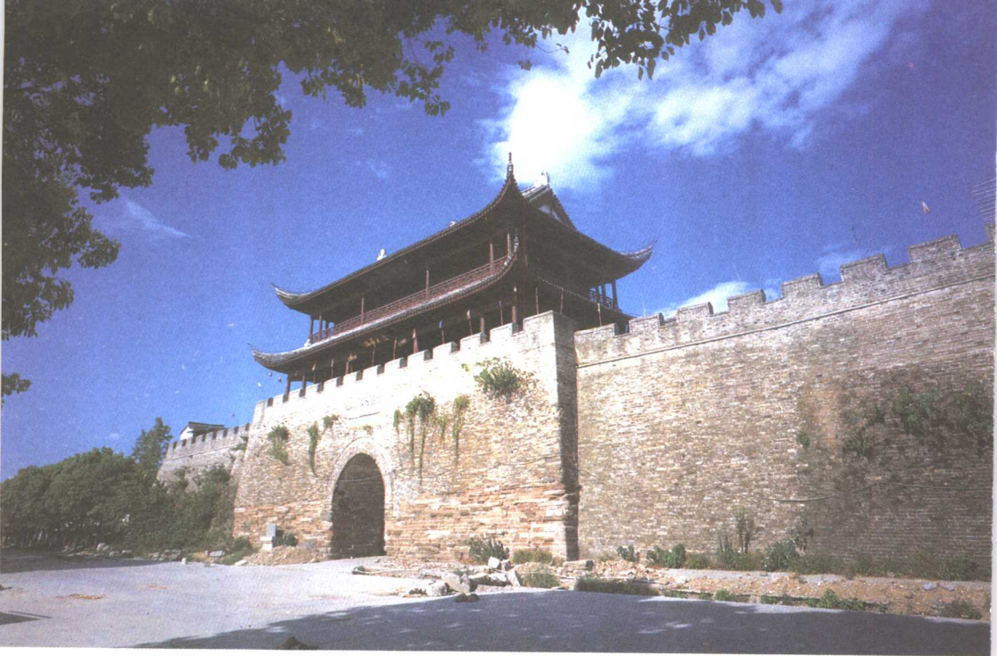
朝京门城楼与城墙
