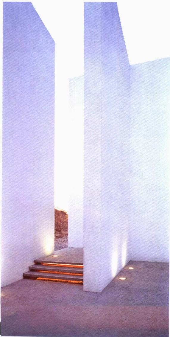
巧合。最初的墙是用混凝土一次浇筑而成的，但拆模板时因为技术原因墙面发花了，而且颜色不对，有锈迹，不匀。最后，设计师高波提出，把不均匀的外墙凿平。一凿，效果出人意料地非常好。做那么多实验都没有达到设计师所想要达到的效果，艺术总是存在着偶然性。于是所有的建筑外立面就成了现在看到的样子，表面是凿毛的，像是精雕细刻的水泥雕塑，不多不少，刚好凿进去两毫米。高波说这是建筑材料和装饰材料的完美结合。
