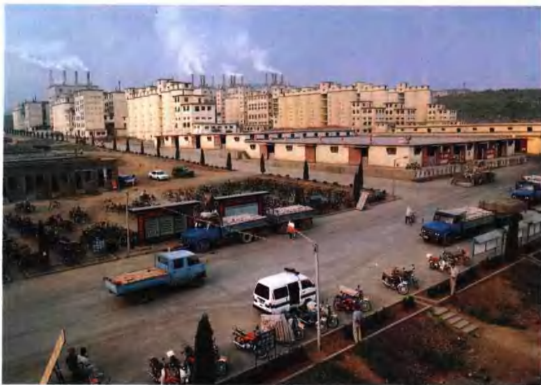
扶持区水泥厂
