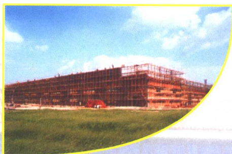
正在建设中的韩国独资企业 青岛新光城篷布有限公司
