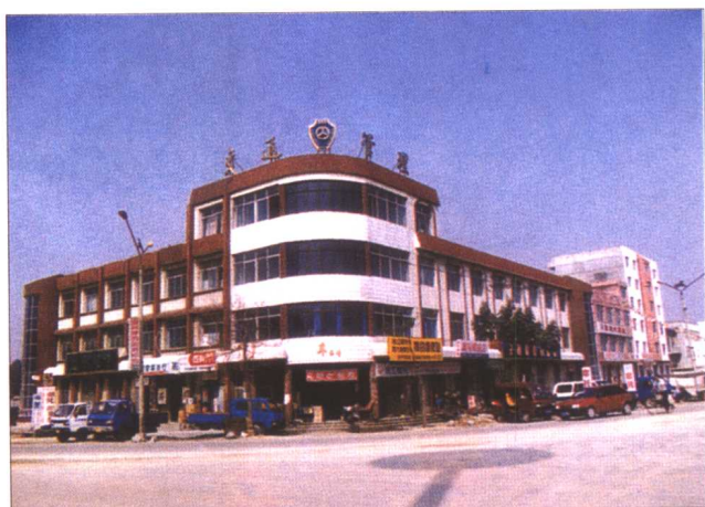
交管所办公楼
