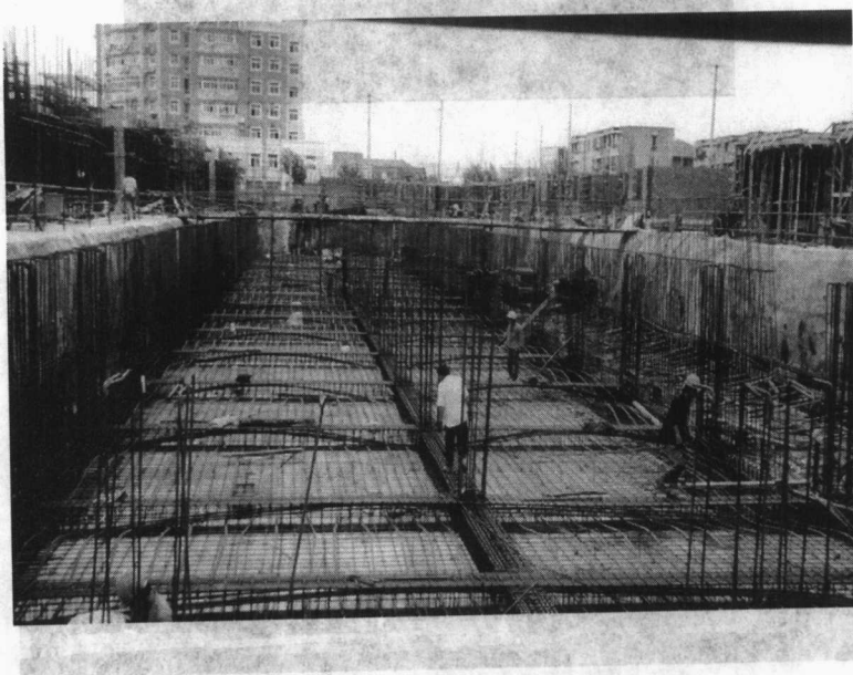
图 1.2-6 上海政德路地下车库超长结构
