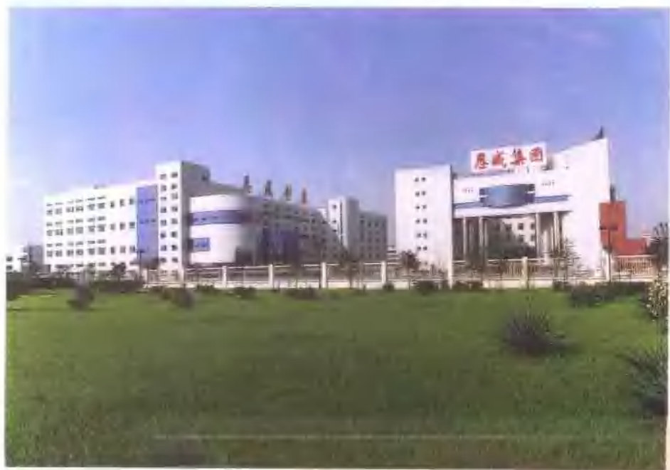
成都恩威集团公司总部。
