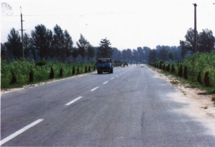
临商公路鄆城路段
