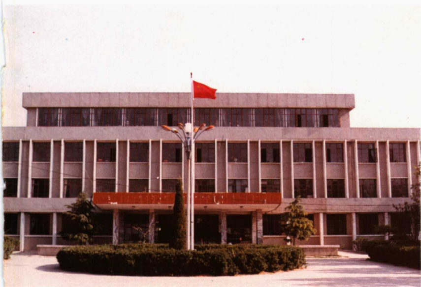
中国共产党鄆城县委员会办公楼
