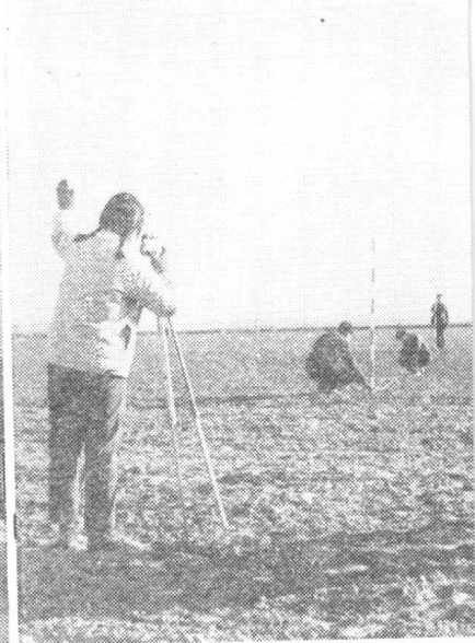
9. 农田林网营造前，正在放线，准备施工
