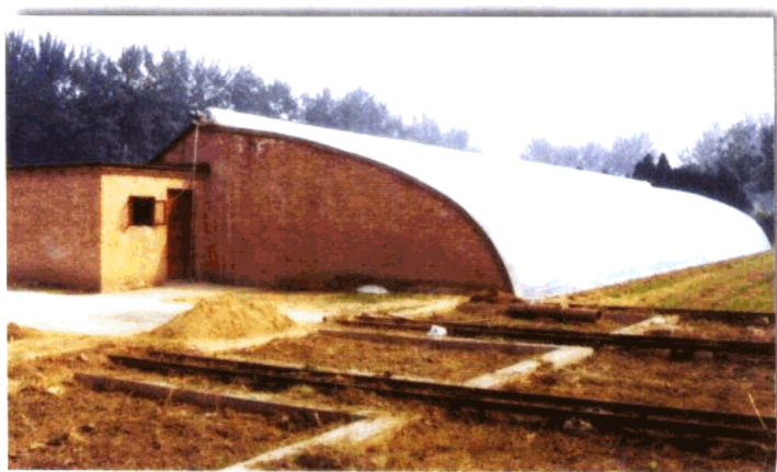
示范日光温室外观
