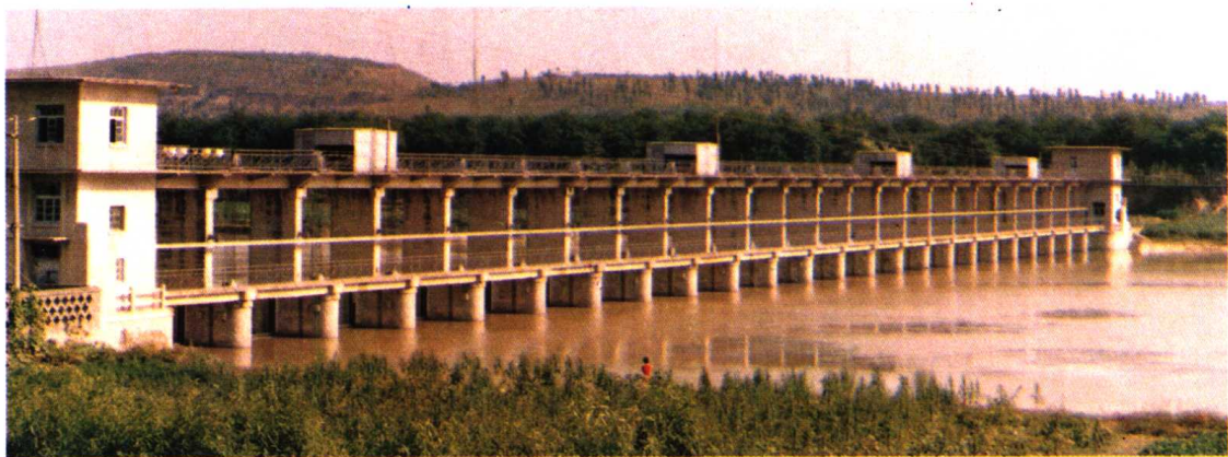
洮赵新河梁山节制闸
