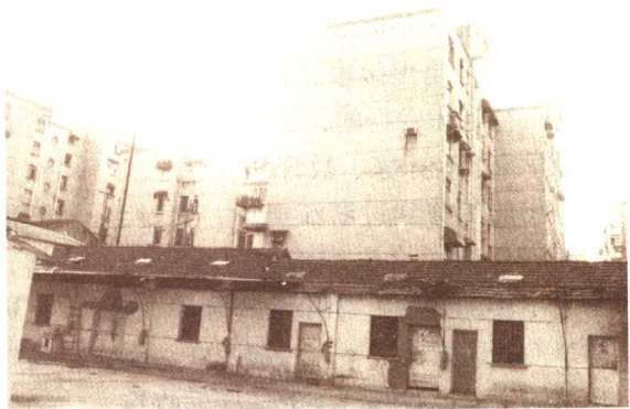
在芥子园旧址上新建的工厂与宿舍楼
