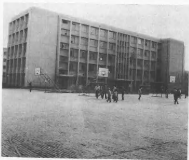
一九八〇年建成使用的教学楼
