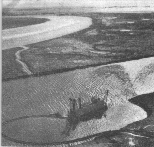
挖泥船在疏浚河道
