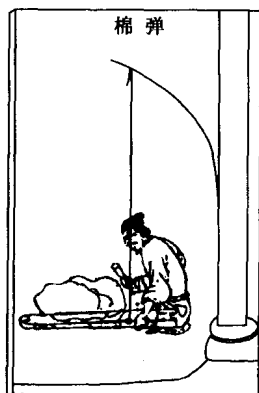
图 1-2 明《天工开物》弹棉
