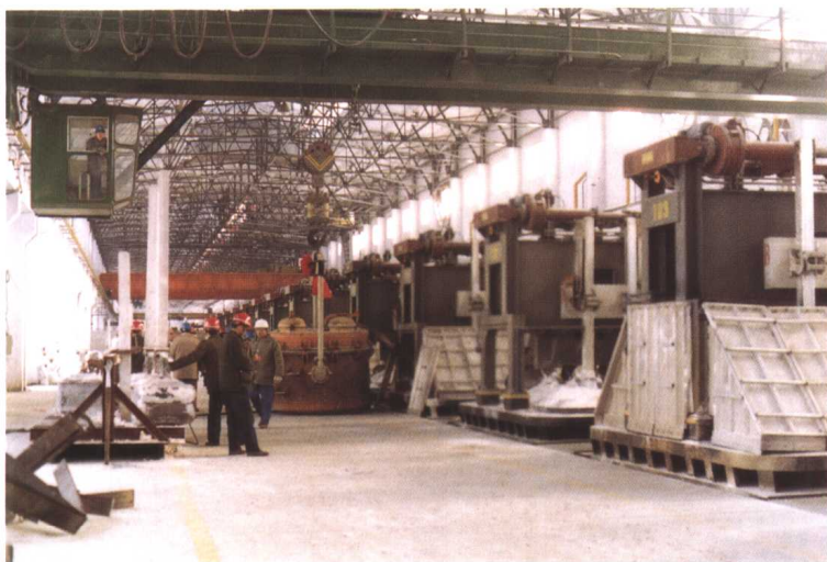
彩图7 抚顺铝厂 200kA 大型预焙槽系列
