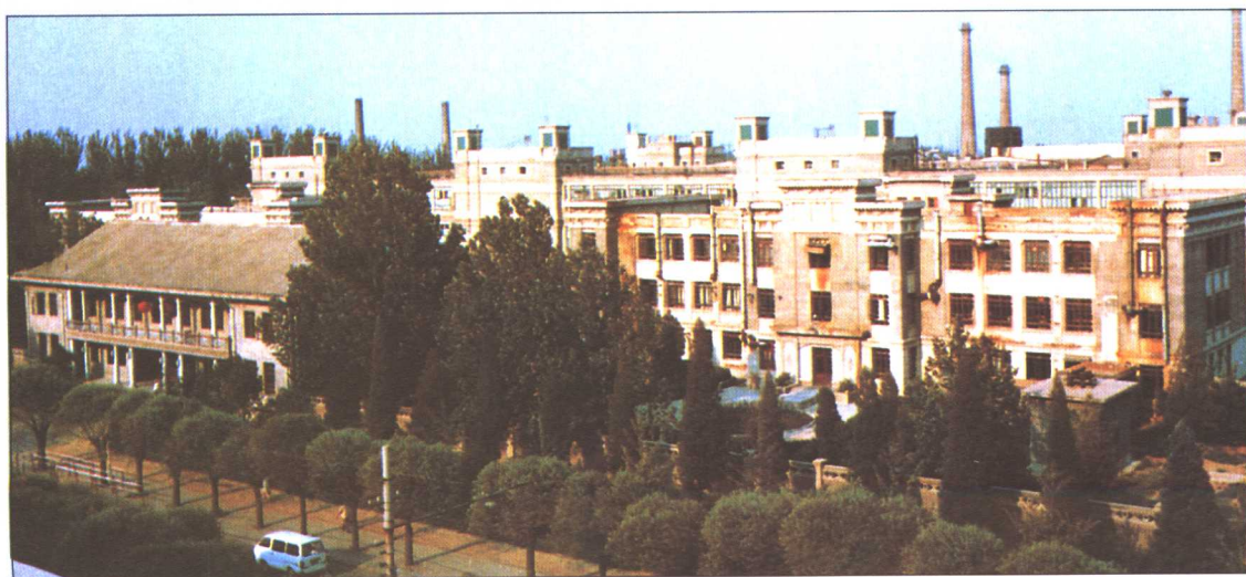
1956 年建成的北京电子管厂外景
