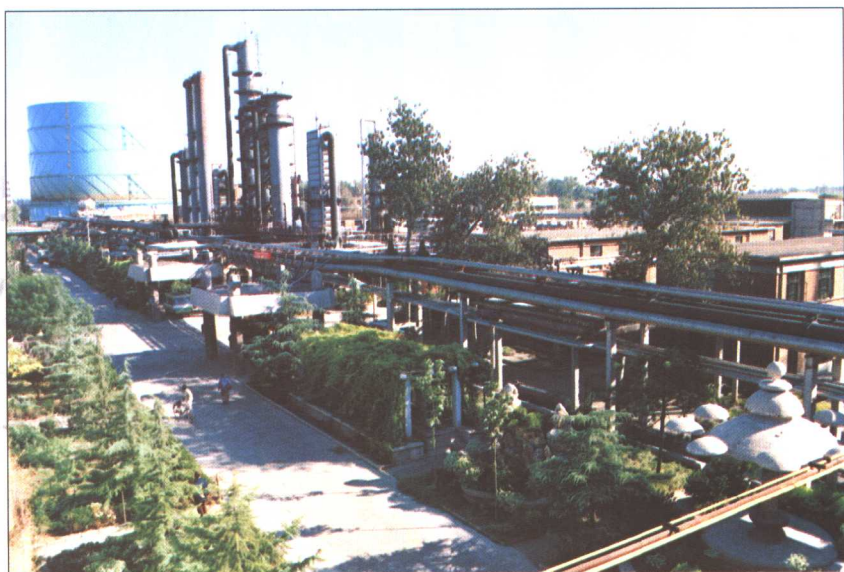
北京电子动力公司煤 气厂一角(摄于1995年)
