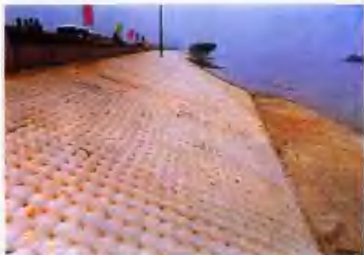
在九江长江大堤加固施工中 采用混凝土模袋护坡技术。
