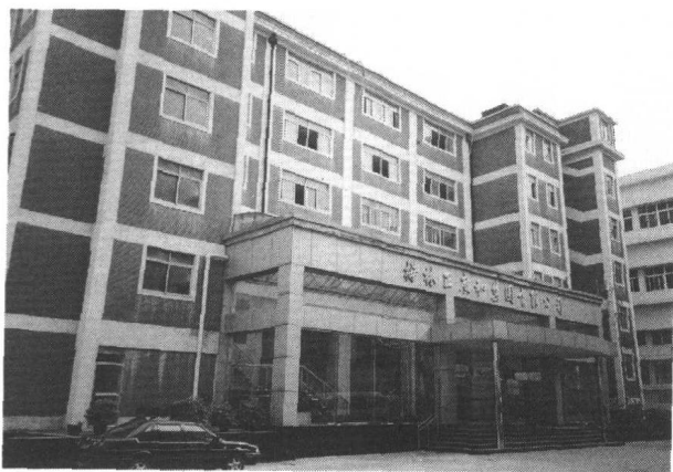
梅林正广和汽水有限公司综合楼(在原厂址新建)
