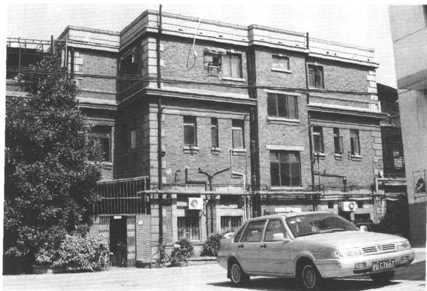
现代派风格建筑的办公楼
