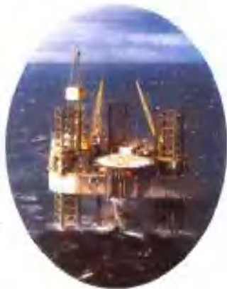
▶ 海上石油平台
