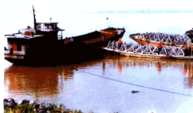
长江钢筋混凝土框架群护岸施工现场
