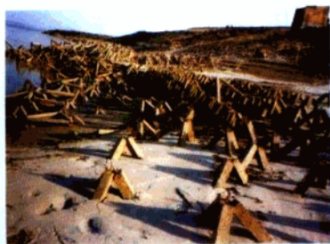
长江九江段赤心堤框架群护岸效果(2)
