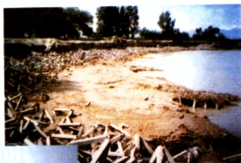
长江九江段赤心堤框架群护岸效果(1)
