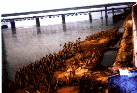
南昌大桥桥头框架护岸
