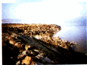
长江九江段赤心堤框架群护岸效果(1)
