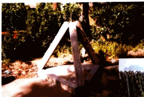
钢筋混凝土框架
