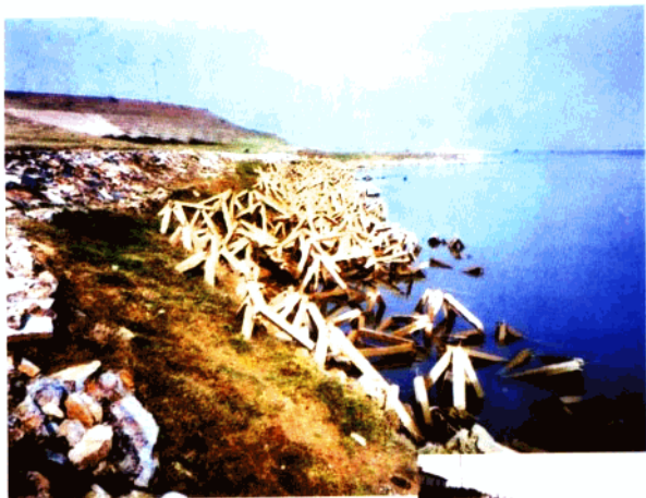
江西抚西堤楼下段框架群护岸 1998年汛后效果
