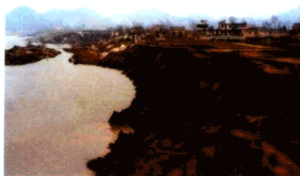
长江马湖堤崩岸实况
