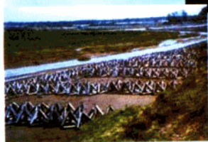
新疆克孜勒苏柯尔克孜自治州阿克陶县盖孜河马场大弯道四面六边透水框架护岸工程及效果图
