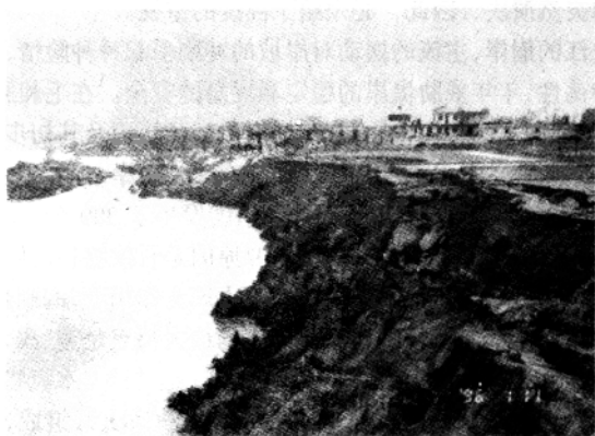
图 1-1 长江马湖堤崩岸实况
