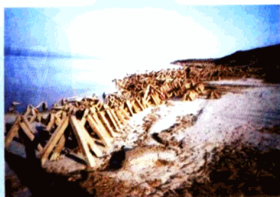
长江九江段赤心堤框架群护岸效果(2)
