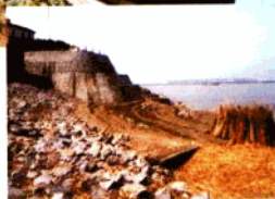
瑞昌市狗头矶下腮框架群护脚效果
