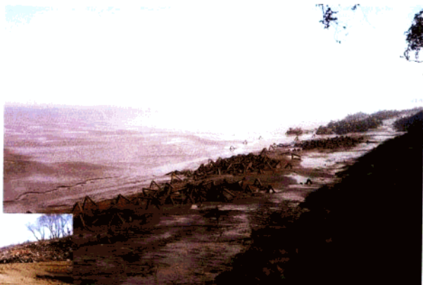
长江九江段东升堤框架群护岸效果
