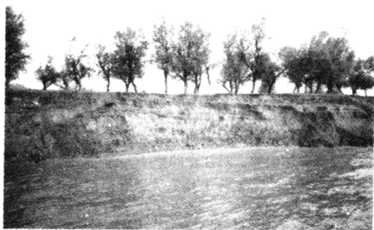
图 1-2 长江牛角芜堤崩岸实况
