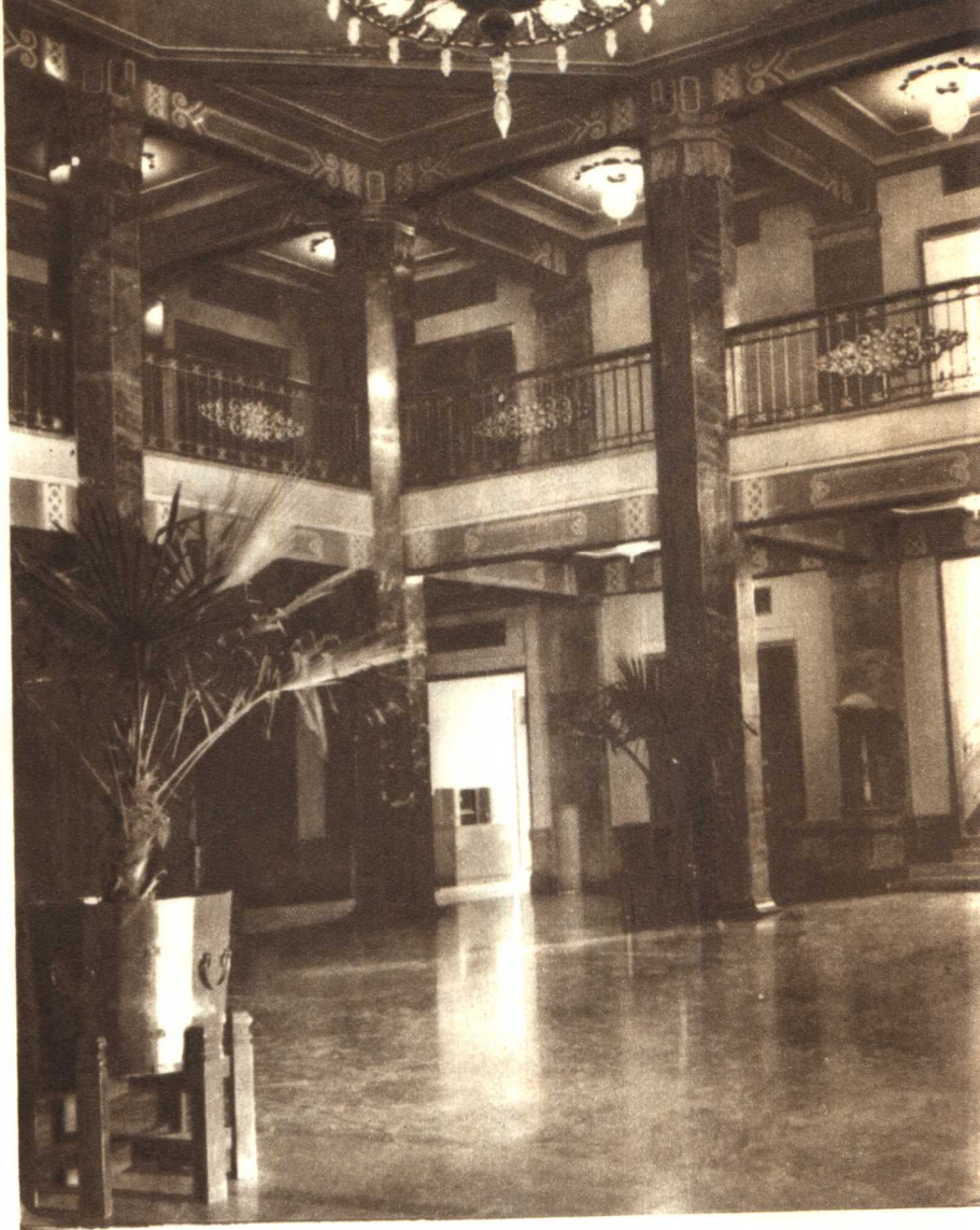
新建的首都劇場的大厅和天桥劇場的外景。
