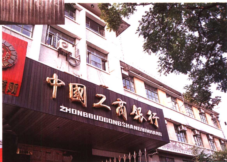
中国工商银行单县支行办公楼
