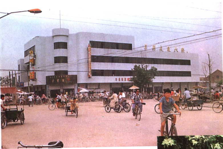
单县交通大楼
