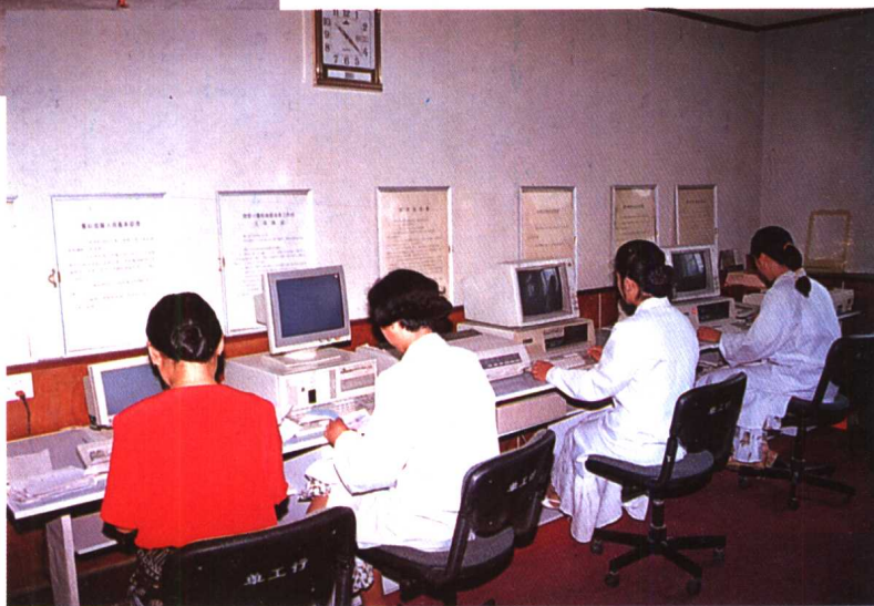
电子汇兑机房
