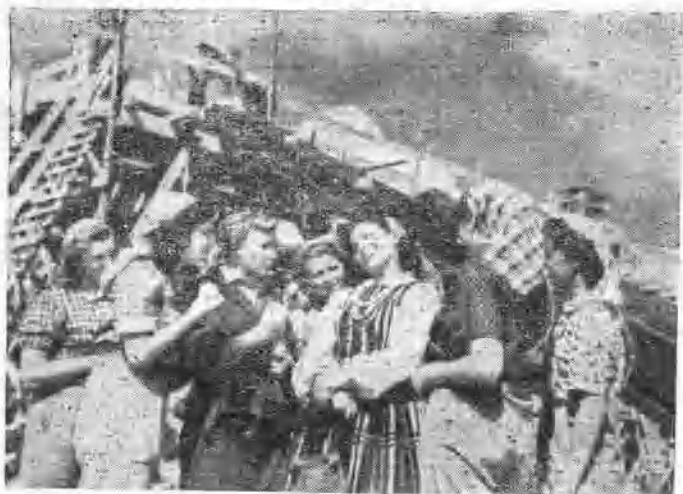
鄉下姑娘罕卡來到建設中的華沙城，在工地上和砌磚女工們談話。
