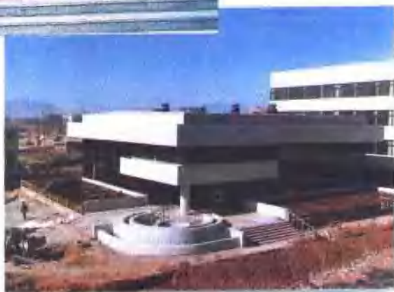
即将竣工的石油大学 (北京) 科学会堂
