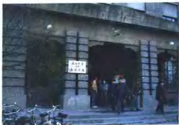
石油大学（北京） 南教学楼
