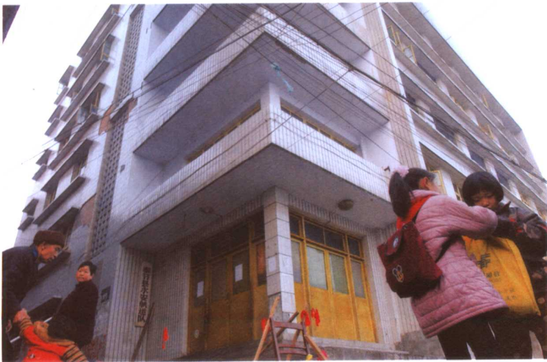
爆破前的永 安镇政府大楼
