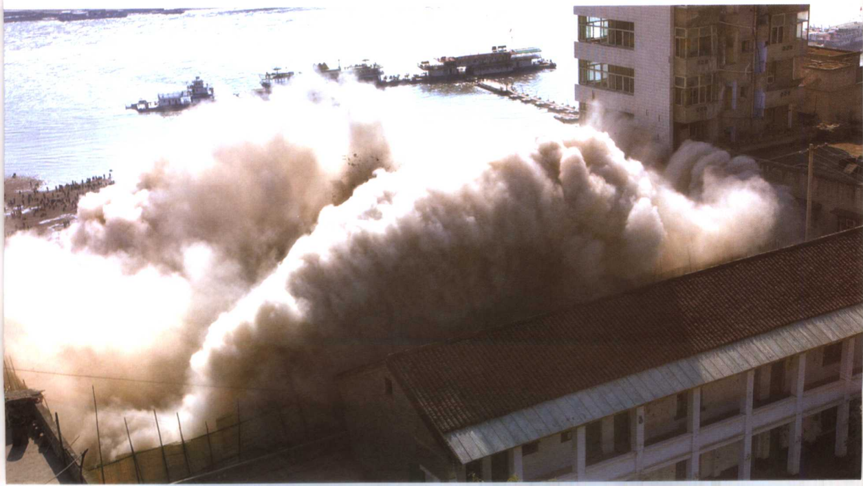
奉节县永安镇政府大楼炸响“三峡第一爆”
