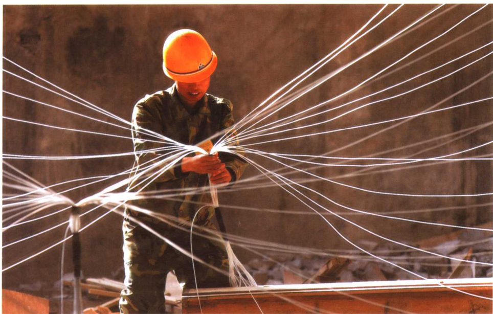
爆破专家正在连接爆破线。这张“蜘蛛网”将启动奉节老城浴火重生的序幕
