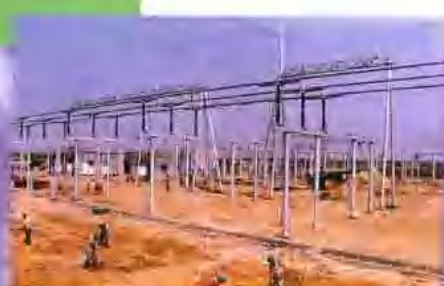
建设中的220KV变电站
