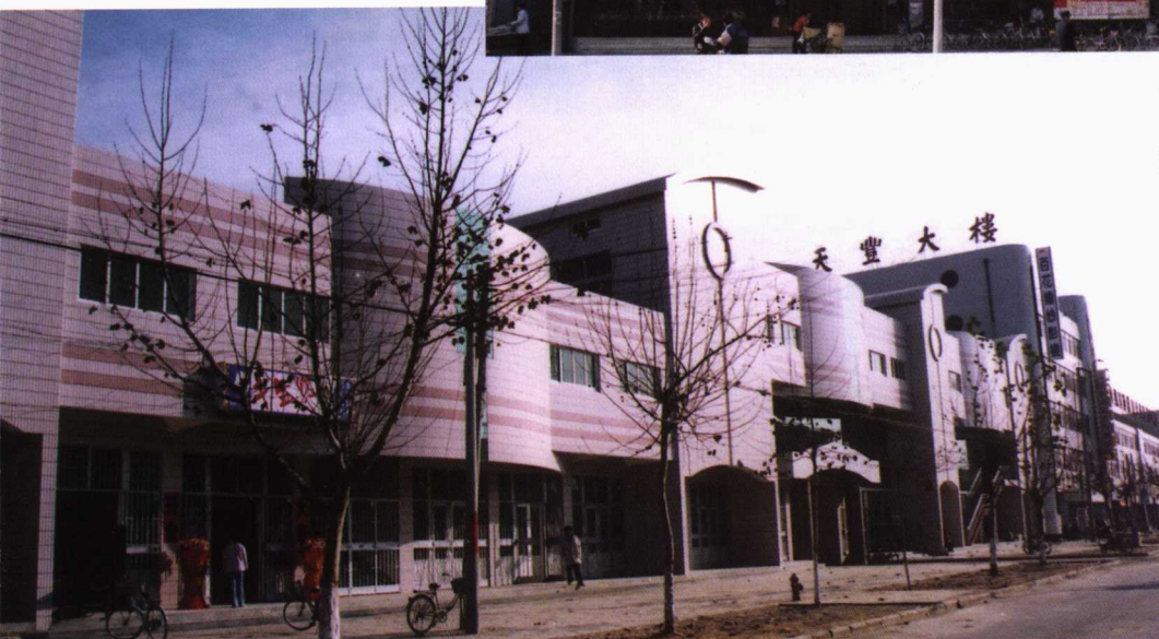
◀ 冠县粮食系统所属天丰大楼
