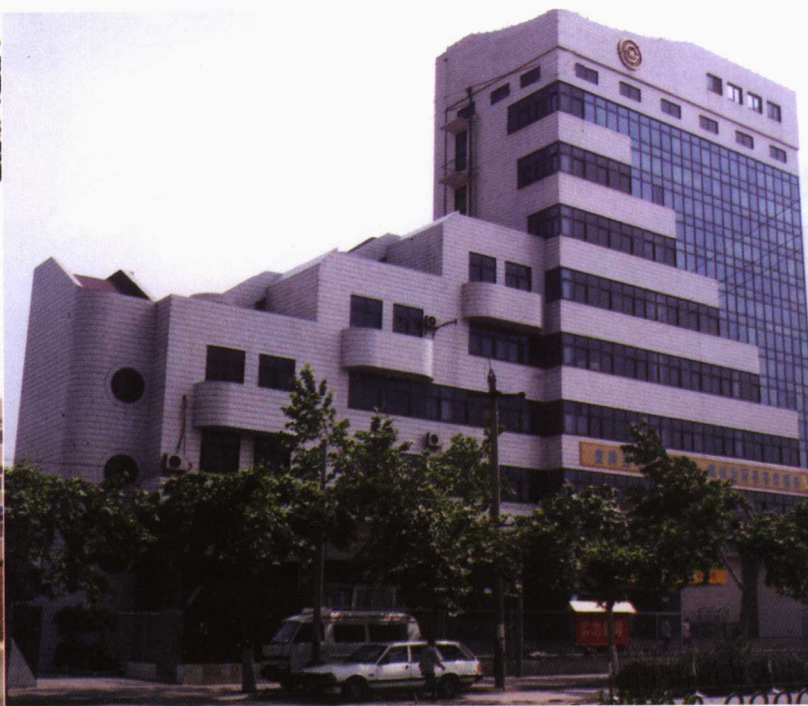
▲ 建设银行冠县支行营业楼
