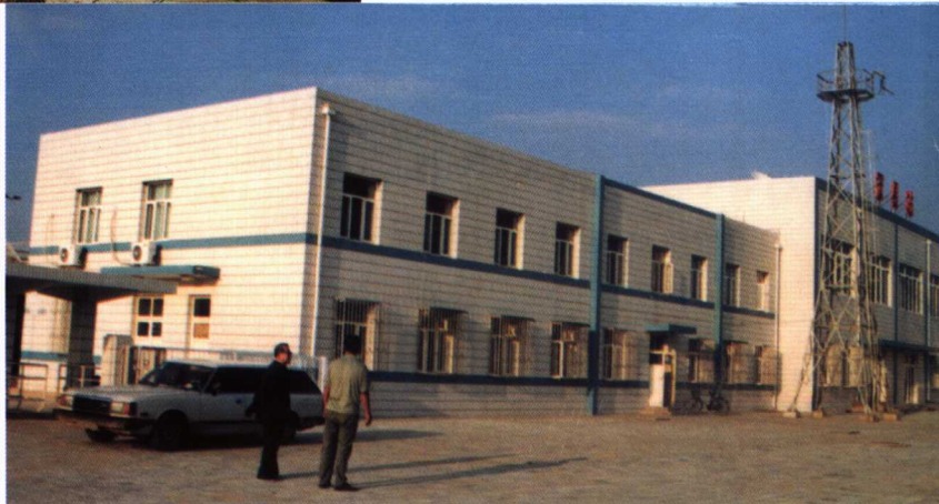
▶ 济邯铁路冠县站
