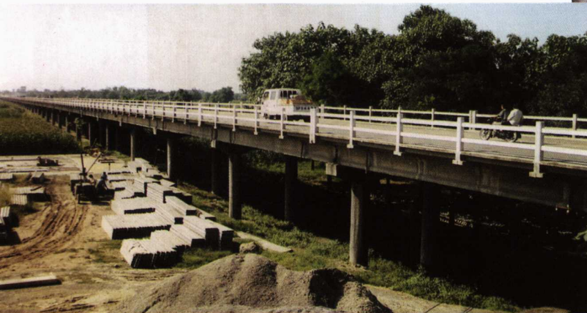
▼ 漳卫河冠县七一大桥
