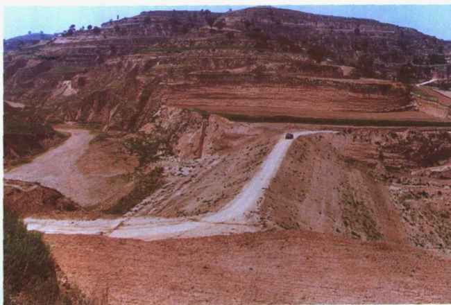
蒲河项目区镇原县治沟骨干工程
