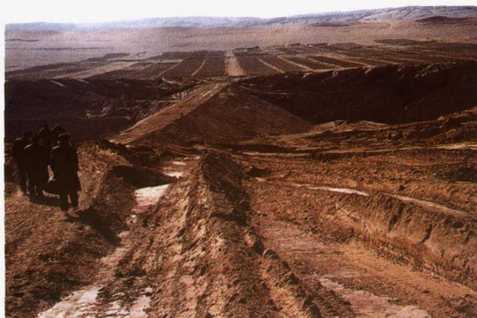
内蒙古鄂尔多斯市东胜区在建治沟骨干工程
