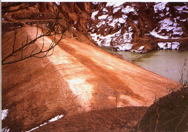
天水市北道区治沟骨干工程
