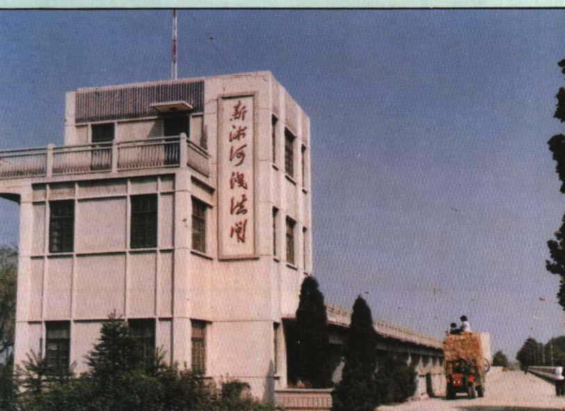
新沭河泄洪闸
