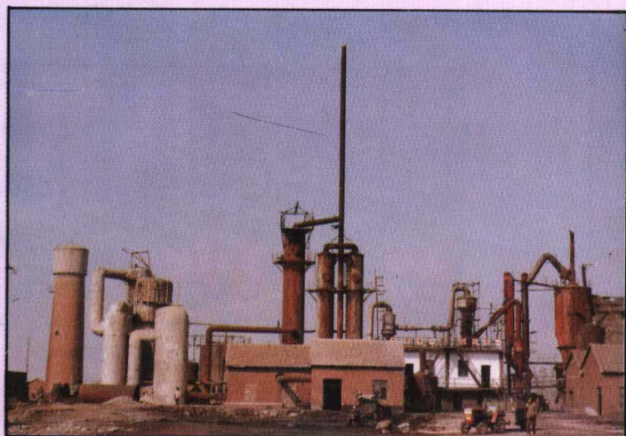
县磷肥厂一角
