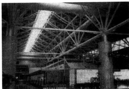
图 1.2.7 南京航空港直接焊接管结构
