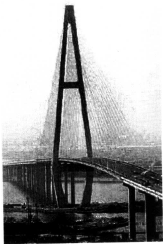
图 1.2.2 独塔斜拉桥——海河大桥
