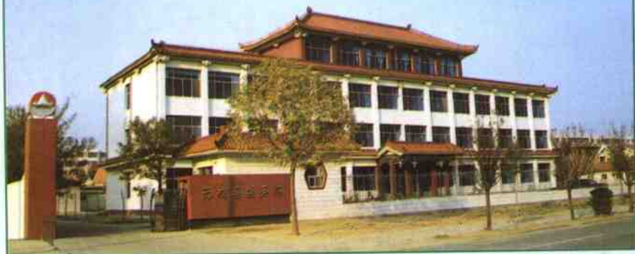
埕口盐场办公楼
